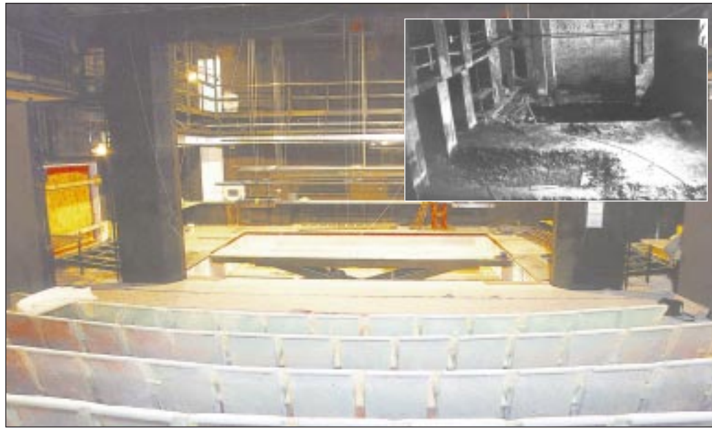
Pohled do obou hledišť divadla – původního i nově rekonstruovaného.
