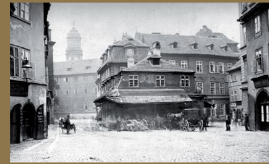
Pohled na Mariánské náměstí (Linhartská ulice) s kovárnou čp. 130, 132, 133. V pozadí část Klementina s věží. (kol. 1870). View of Mariánské náměstí (Linhartská ulice) with forge buildings no. 130, 132, 133. In background part of Clementinum with tower (around 1870).
