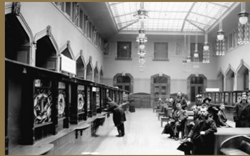
Celkový pohled do interiéru domu čp. 2 (Magistrát) - hlavní pokladna na Starém Městě. Kříženecký, Jan / březen 1913. General view of interior of building no. 2 (City Hall) – public treasury in Old Town. Kříženecký, Jan / March 1913.
