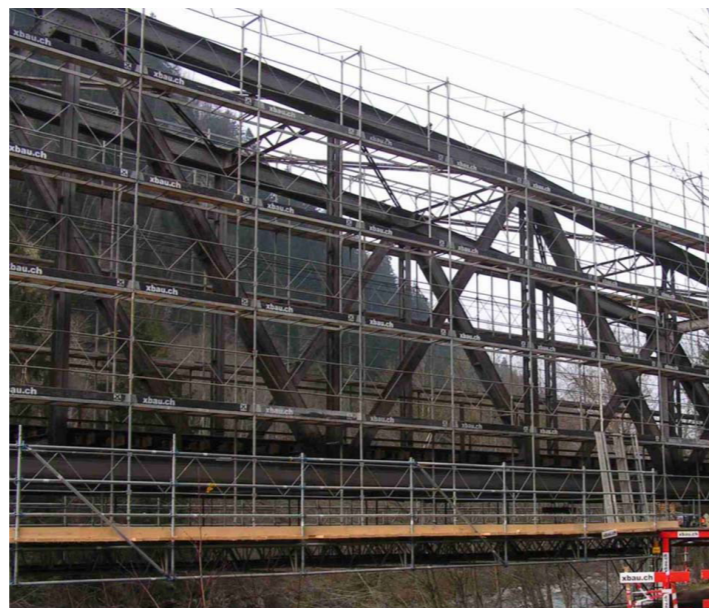
↓ Příprava provizorní konstrukce pro pískování částí mostu v minimálním prostoru.
