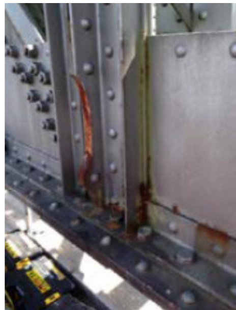
Detaily opravovaných styčnicků
