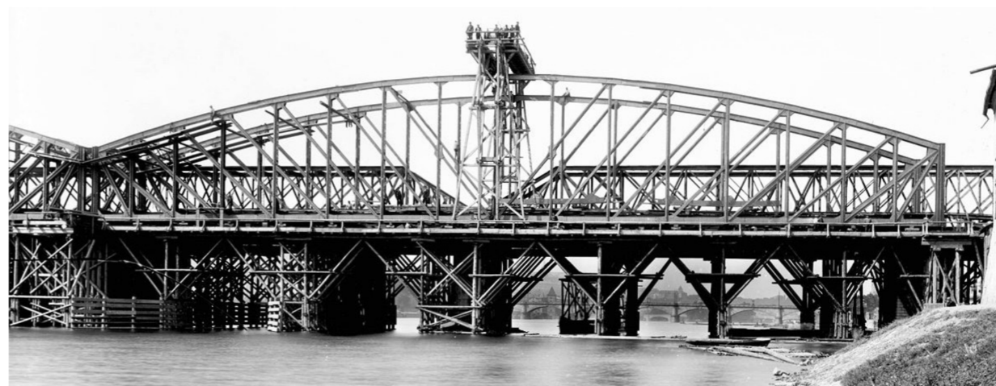
↑ výměna původního mostu za nový 1901
