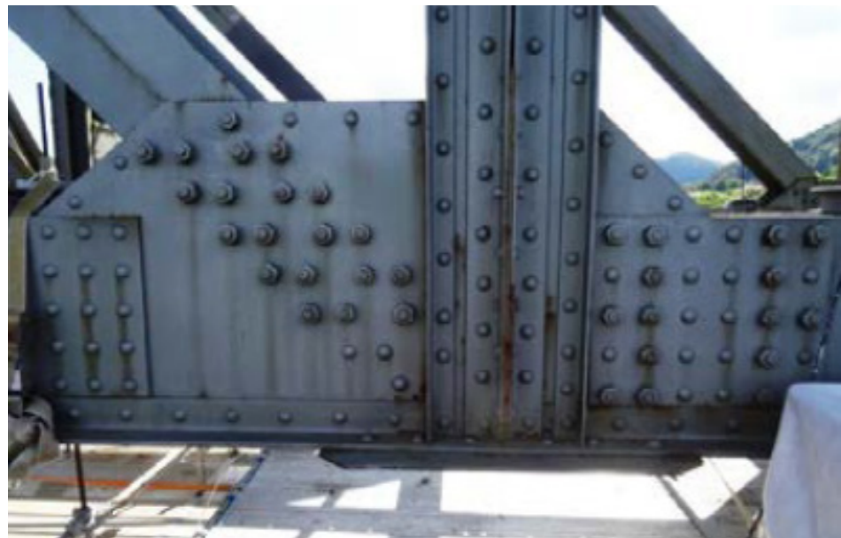
Detaily opravovaných styčnicků
