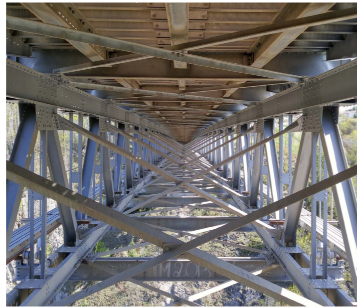
↑ Přidaná část přenáší část zatížení. To snižuje požadavky na stávající prvky. Některé prvky pak vyhovují navzdory ztrátě průřezu.
