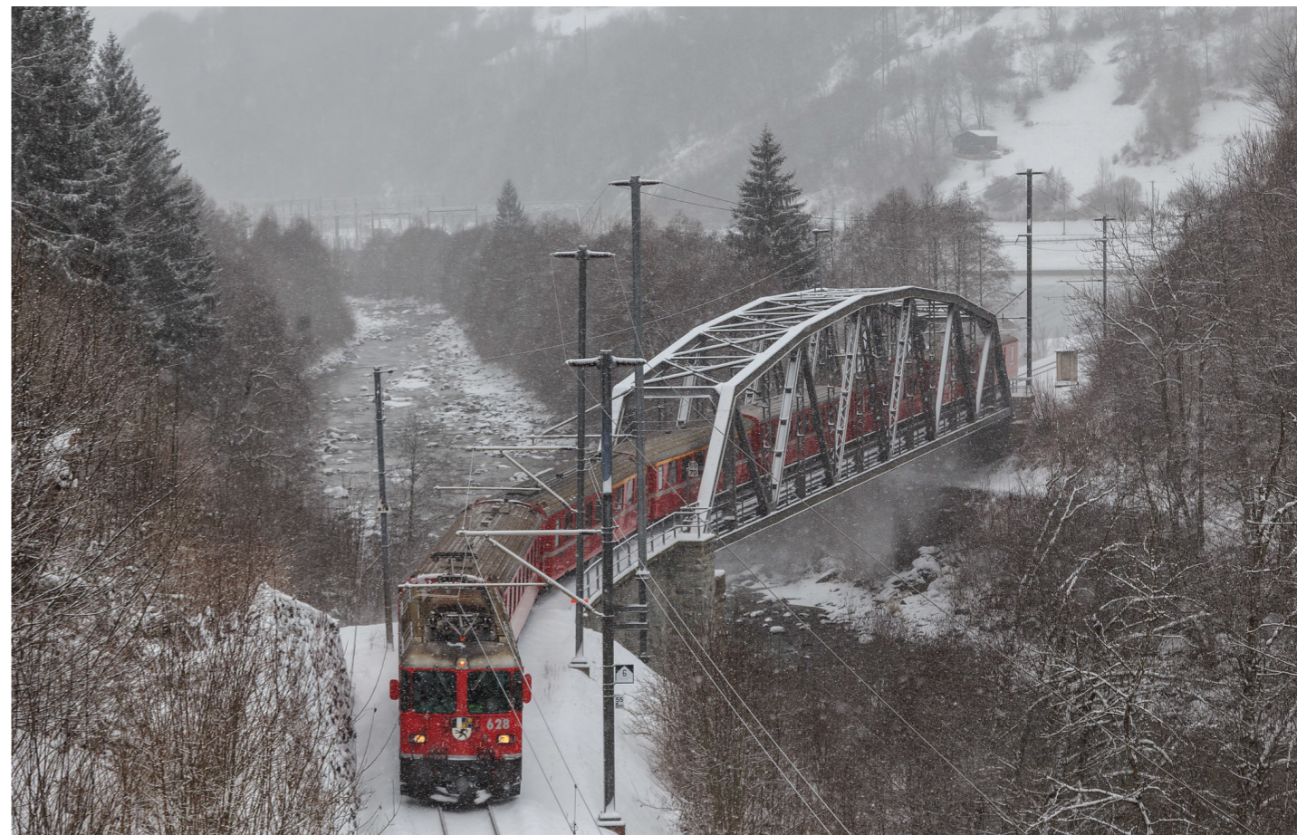
↑ Opravený most v provozu.
