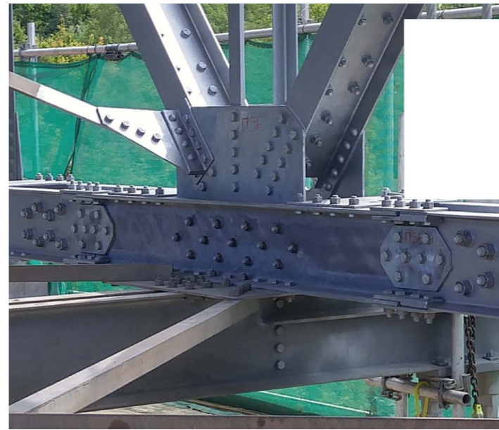
↑ Výměna styčnicku byla dokončena během několika hodin. Každý styčnick byl geometricky podobný, takže bylo možné použít opakovatelný dočasný přípravek
