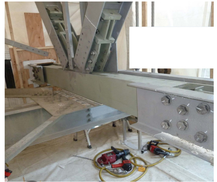
↑ Dočasný styčnick, který přenáší zatížení, zatímco je nová ocel namontována a přišroubována.
