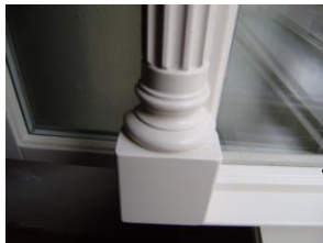
detail vyměněné zdobné části okna
