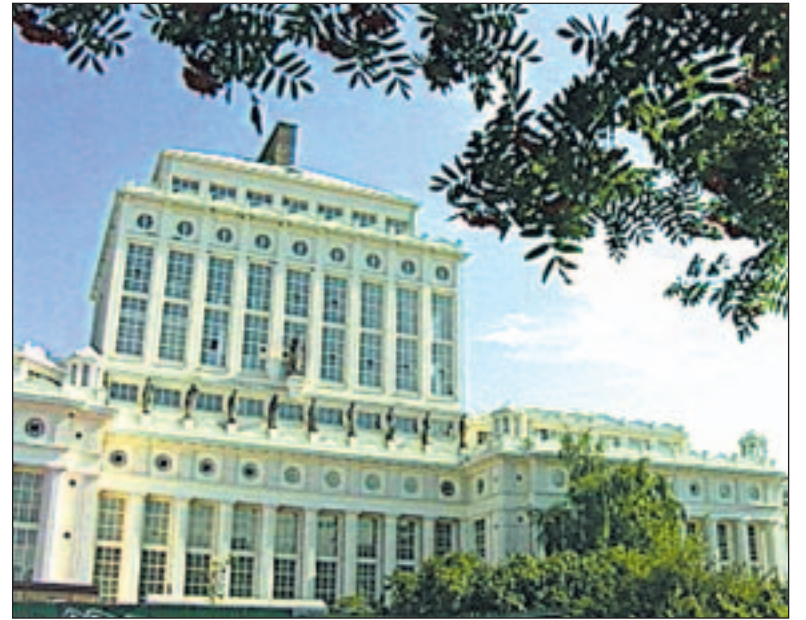
Majestátní stavba podolské vodárny vznikla ve dvacátých letech minulého století, jejím architektem byl Antonín Engel. V objektu staré filtrace vody můžete navštívit expozici Muzea pražského vodárenství – bližší informace zjistíte na čísle 02/210 95 473.
