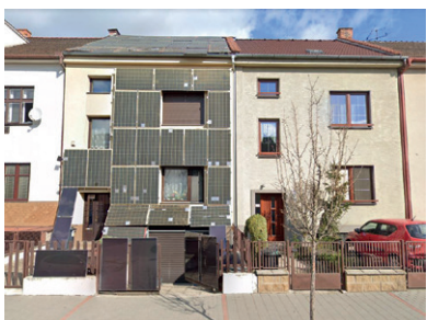
Negativní příklad instalace FVS na plášť domu v Brně-Židenicích, bez vztahu k charakteru objektu či místa, narušuje celkovou kompozici objektu a významně se uplatňuje ve vnímání širšího území, viditelnost FVS v blízkých i dálkových pohledech, kontrastní řešení vůči podobě okolní zástavby.
